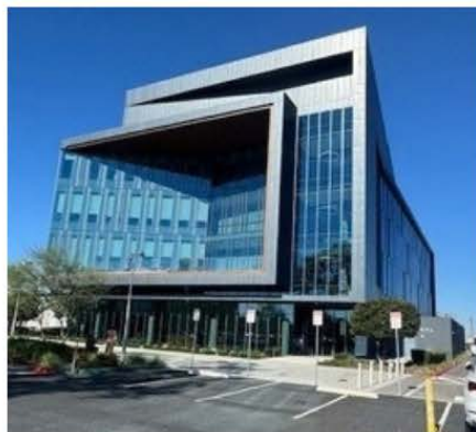
Edificio MRL del Instituto Lundquist
